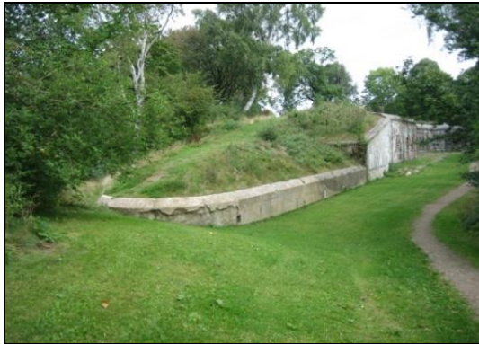
Billede 12 - Støttevæg ved fortets SV hjørne
