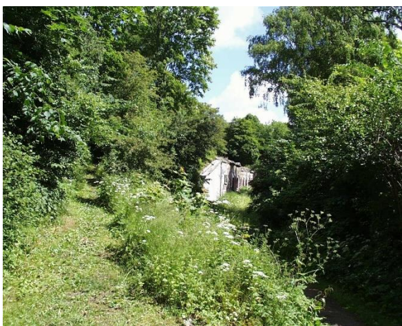
Fortunfortet inden rydningsarbejderne i 2003.
