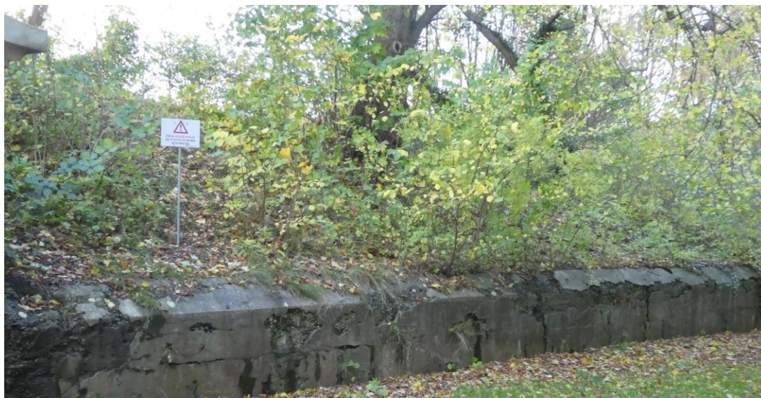
Udsnit den ødelagte støttemur
