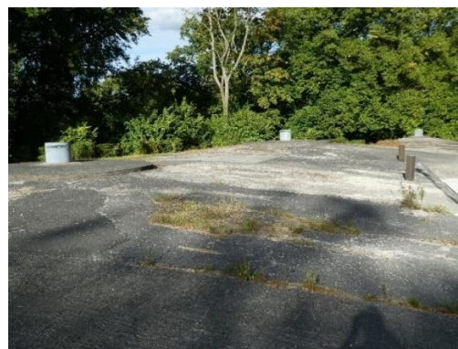
Det ødelagte betontag
