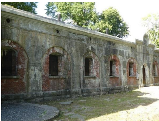
Et udsnit af fortet med den renoverede tagrende og gesims.
