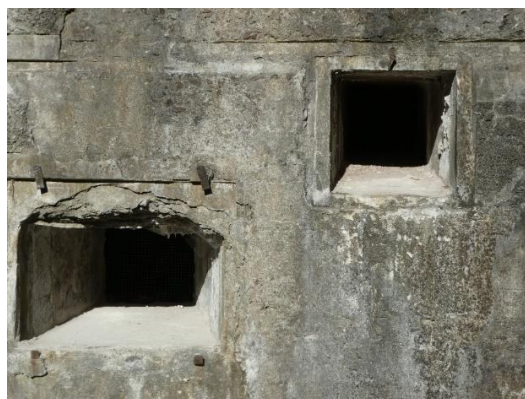
Skydeskår, der trænger til renovering
