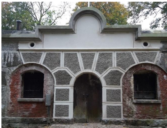
Det smukt istandsatte indgangsparti og hovedport med den nystøbte betontagrende og gesims
