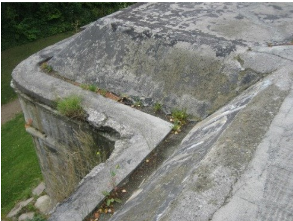
Foto fra vedligeholdelsesrapport, der viser tagrenden ved nedløbet til diamantgraven.
